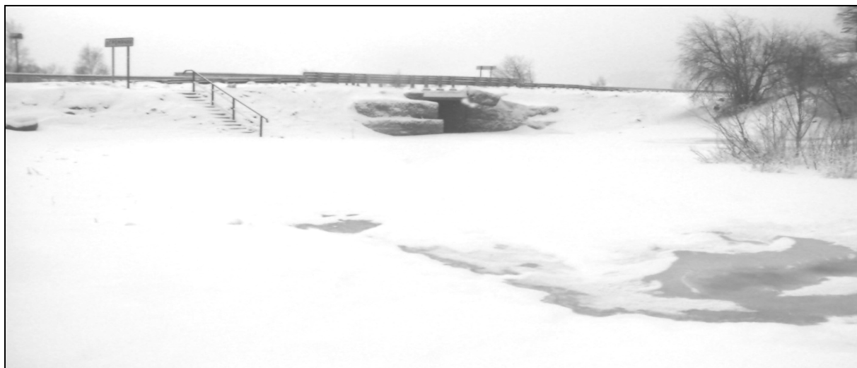
Рис. 1. Крепление подмостового перехода габионами. Дорога Иркутск-Чита, 426 км. Толщина снежного покрова – 0,5 м, толщина льда – 0,4 м. В холодные зимы образуется наледь
